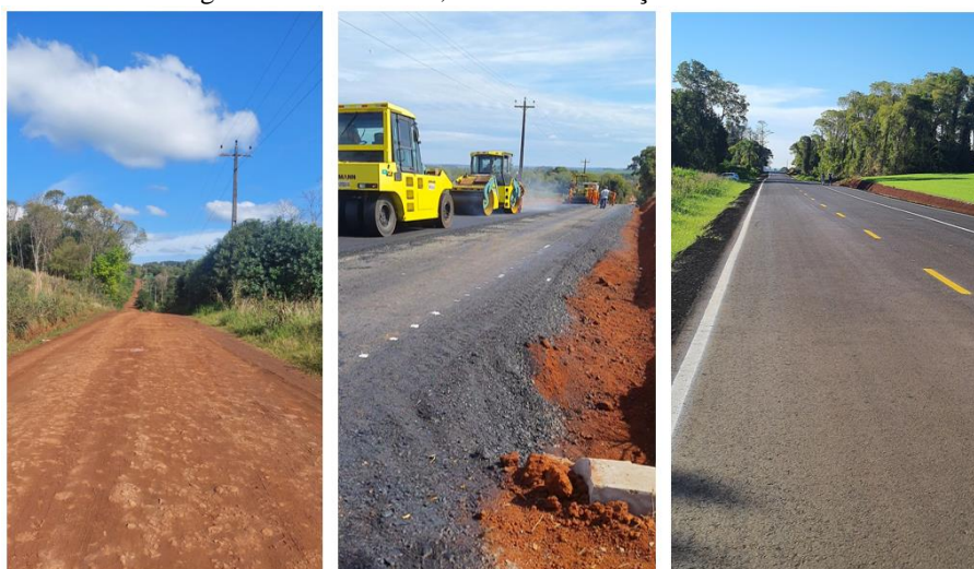
Figura 2: Trecho antes, durante a execução e concluído
