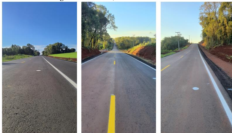
Figura 6: Trecho 1, 2 e 3 locais de ensaio
