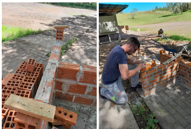
Figuras 05 e 06: Processo de execução.
