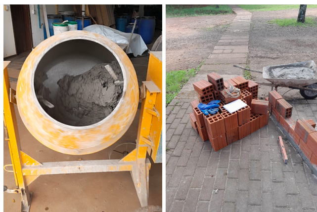
Figura 03 e 04: Processo de execução.
