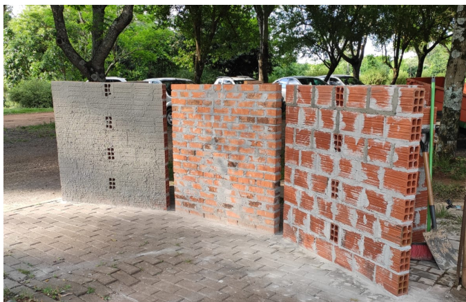
Figuras 07: Parede finalizada.
