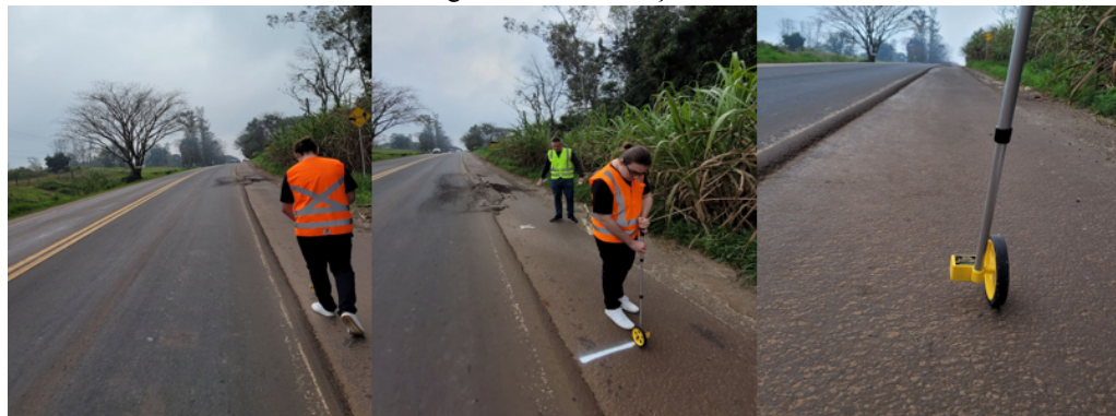
Imagem 03: Demarcação das estacas.
