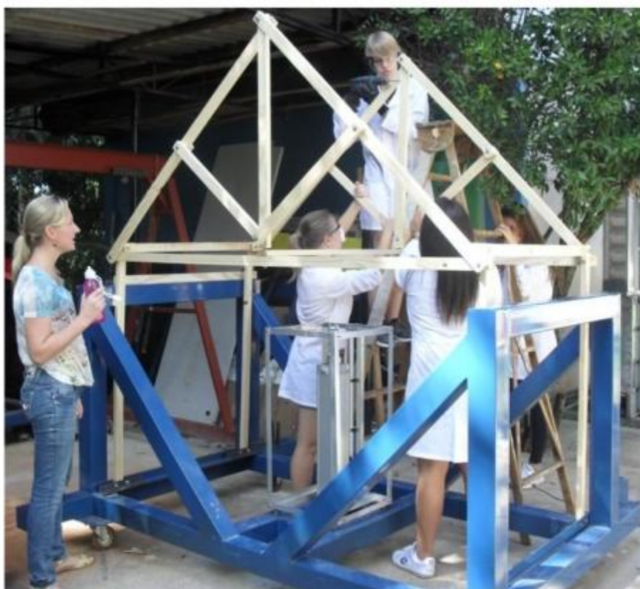
Figura 1 – Bancada didática de ensaio de pórticos, montagem da estrutura e preparação para os testes.
