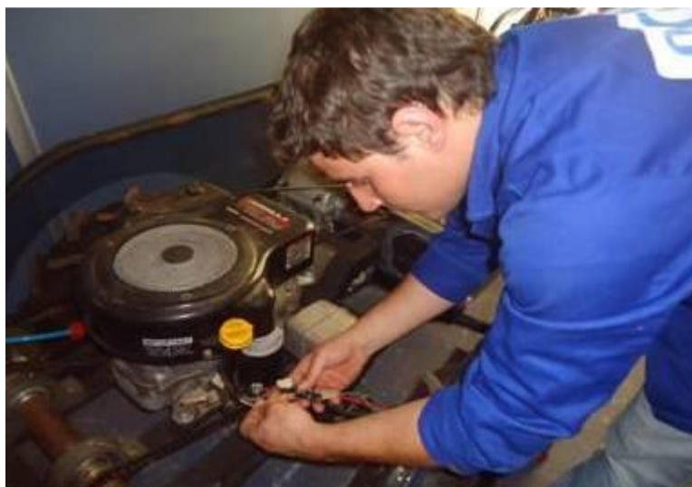
Figura 2. Fotografia da instalação do novo sistema elétrico.
