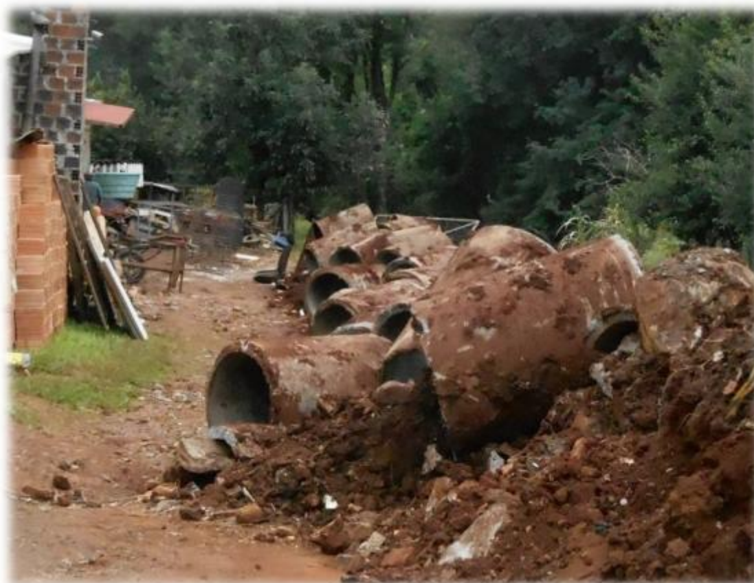
Imagem 1. Descaso dos órgãos competentes com o esgoto pluvial.
