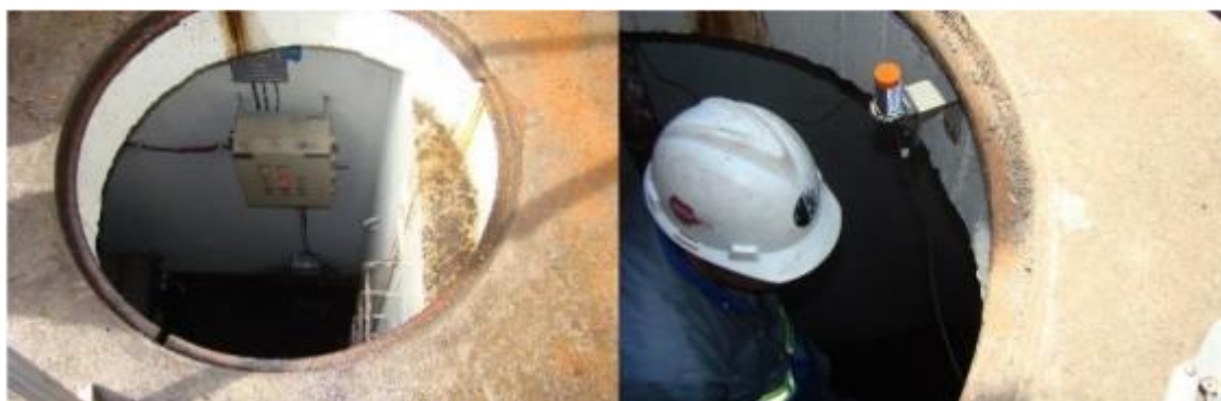
Figura 1 - (a) Acesso à câmara Subterrânea (b) Instalação do Sensor Indutivo
